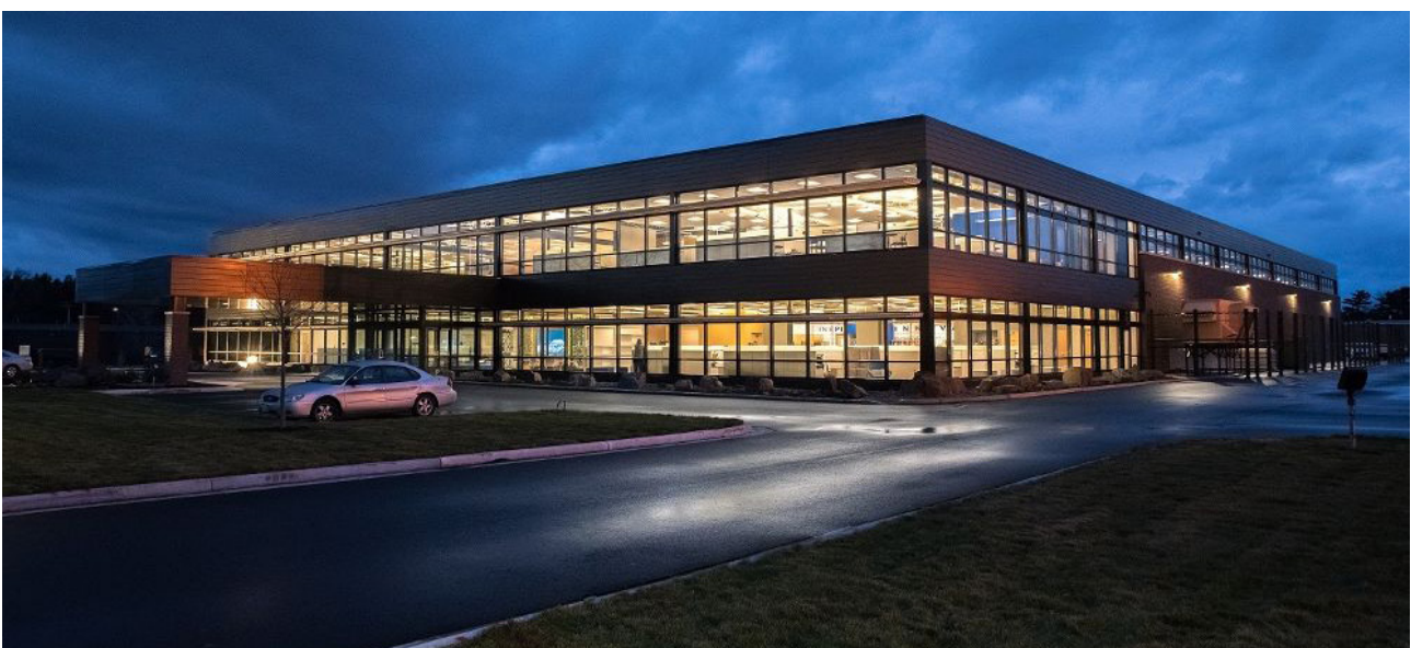
Oficinas de Accurex Schofield, WI
